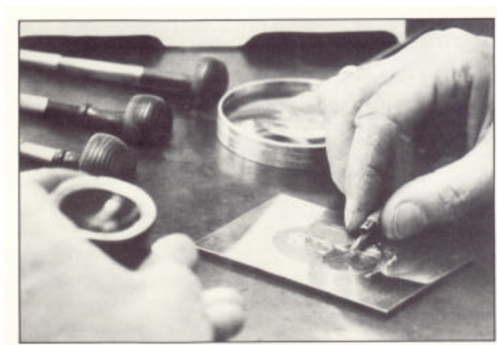
Figura 26 – Gravura a buril sobre placa de metal para impressão de papel moeda 37 .
